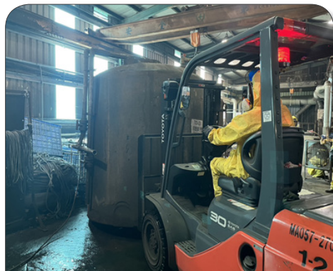
1. 堆高機搬運廢酸貯槽至地面作業
